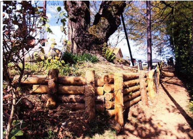
説明 土手の杭修復工事後
